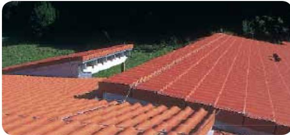
Mit dem Braas 7GRAD Dach ist erstmalig die Eindeckung eines flach geneigten Daches schon ab 7° mit Braas Dachsteinen möglich. Zu einem kompletten Braas 7GRAD Dach gehören verpflichtend die Harzer Pfanne F<sup>+</sup> mit Regensperre sowie die Unterkonstruktion Divoroll Top RU auf Schalung mit abgestimmter Divoroll Dichtmasse und Divoroll Anschlusskleber. Weitere Systembestandteile sind je nach Anforderung ausschließlich zulässig (siehe Verlegeanleitung zum Braas 7GRAD Dach).
