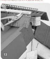
Beim Firstendstein geloch-ten Lüftungssteg des Aero-Firstelements am Firstanfang um 60 mm kürzen, am Firstende bün-
